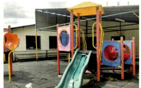
Taman permainan rosak akibat tidak diselenggara oleh pihak pengurusan.
